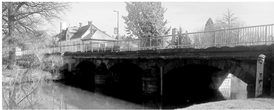
Most přes potok Mastník v Nádražní ulici
