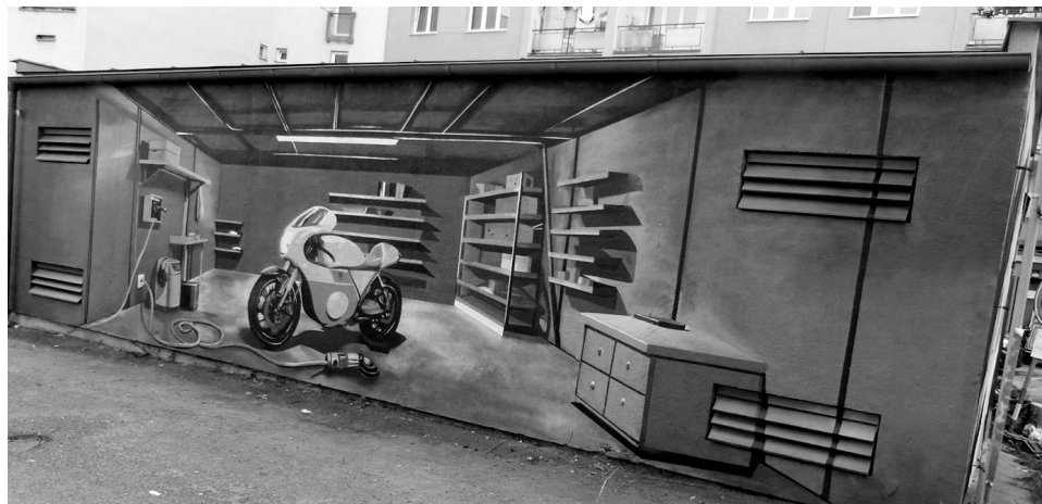
Nová malba na fasádě trafostanice doslova září.
